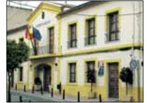
Når temperaturen på den helt nye barneskolen i Albir passerte 34 grader var rådhusets løsning noen mobile vifter.
